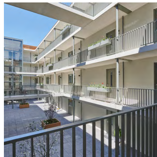
gevels met een structuurpleisterlaag
