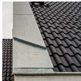
zinken dakafwerking met watersturende elementen
