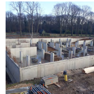
wanden van beton
