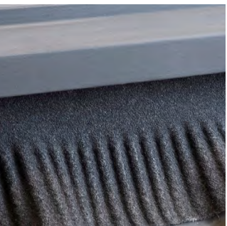
slab onder een kozijn waterkerend
