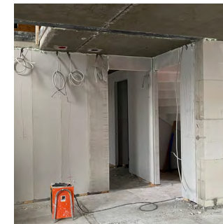
wanden van gasbetonblokken
