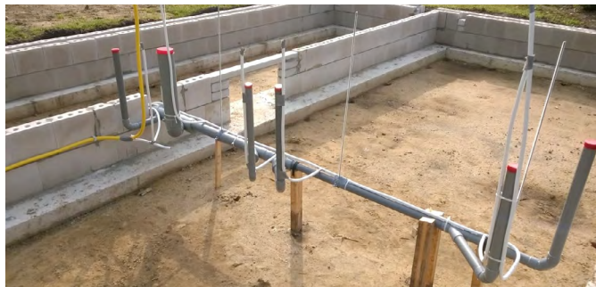
riolering onder de vloer
